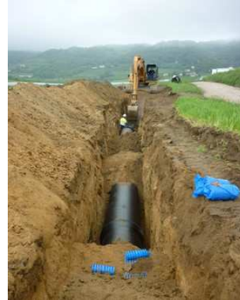
Canalisation Ø 800 mm
