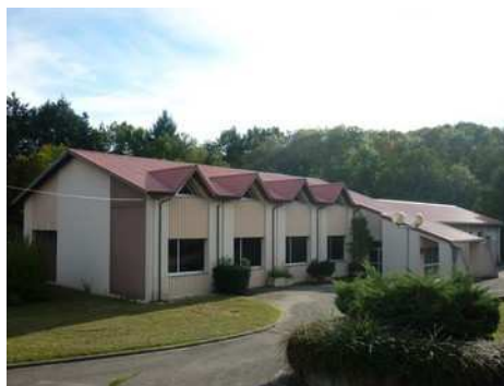
Station de Pompage (St didier/Riverie)
