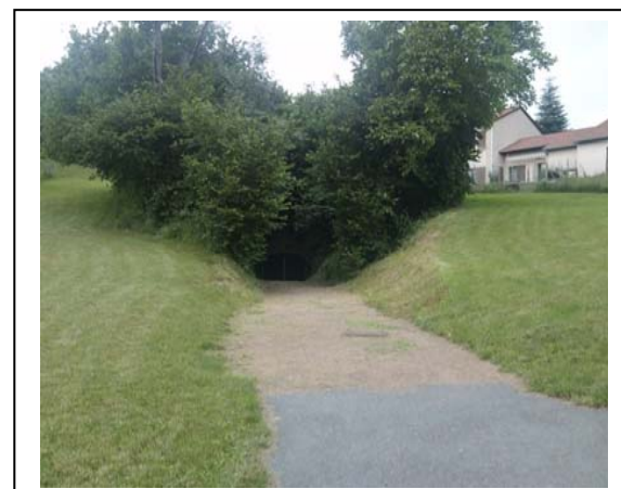
Accès au tunnel
